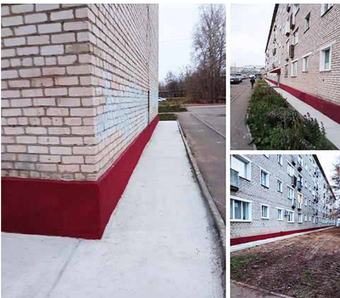
В октябре 2021г. капитально отремонтирован фасад дома ул. Советская, 87
