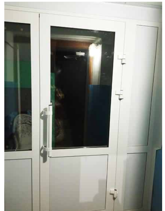
Ул. Советская, 56. Замена входных дверей в подъездах с 1 по 4
