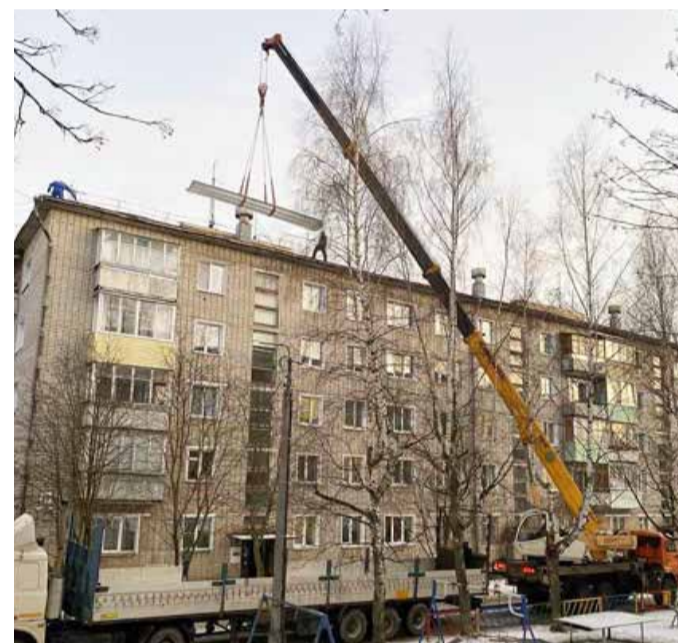
Капремонт в доме № 11 на улице Опарина. Подъём материалов на крышу
