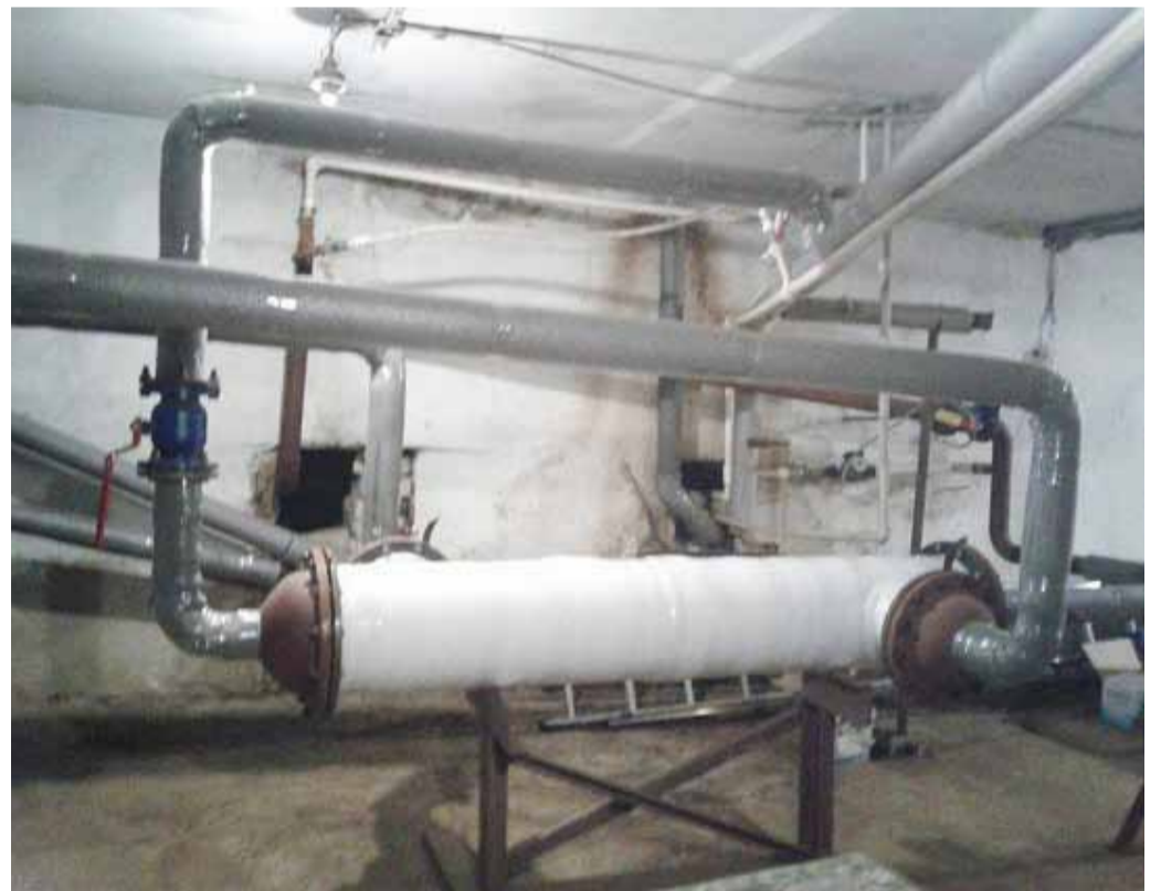
Теплоузел ул. Советская, 11Г. Бойлер после замены.
