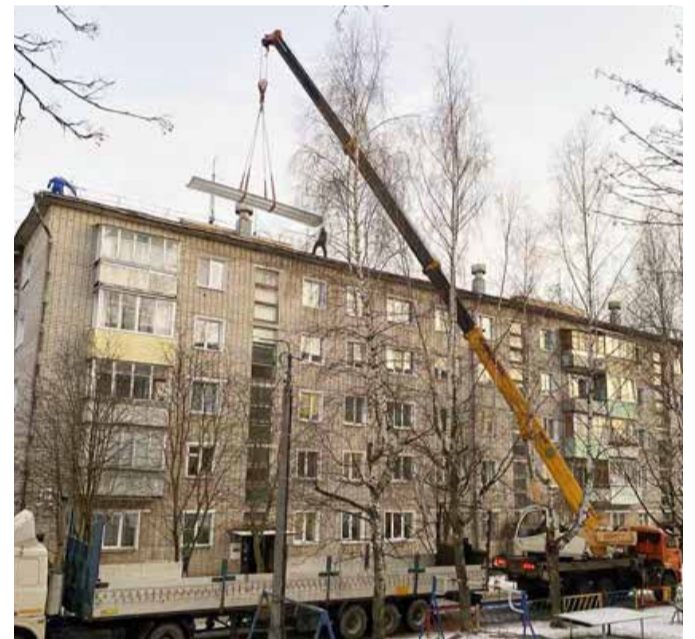
Капремонт в доме № 11 на улице Опарина. Подъём материалов на крышу
