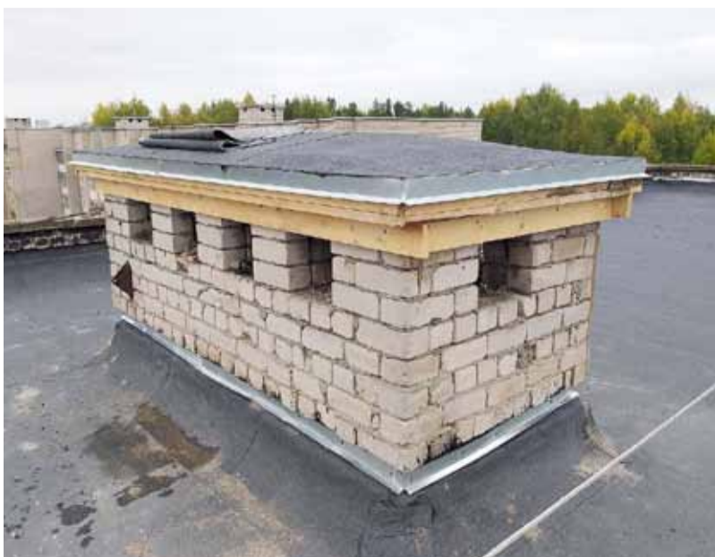
Ул. Кирова, 59. Отремонтированная вентиляционная шахта
