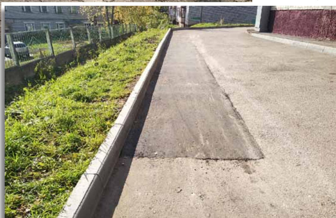
Ул. Мопра, 8, на месте раскопок КТК. Повреждённый участок территории до и после вмешательства управляющей компании
